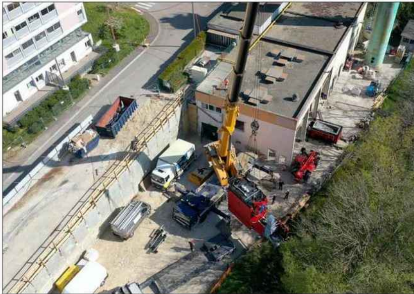
Une grue de 220 tonnes a été nécessaire lors de la réception des nouvelles chaudières. Photo ER/DR
